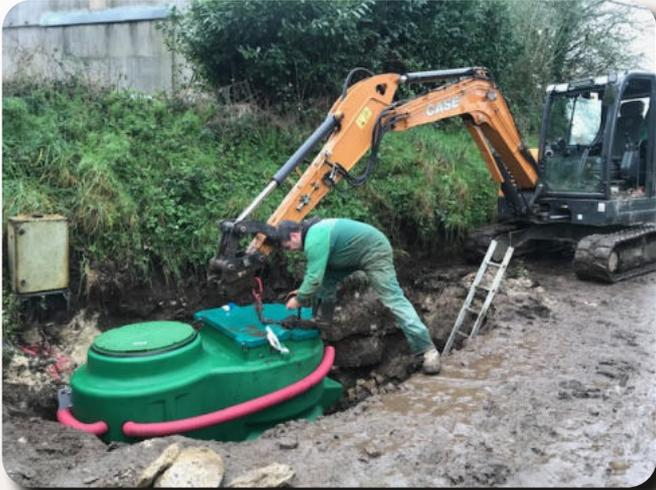
Conformément à la programmation des travaux, le remplacement du poste de refoulement desservant la partie Sud/Est du bourg a été réalisé, fin février, par les entreprises retenues. Un engrillagement de ce nouvel équipement, situé en bordure de voirie, lui confère une meilleure sécurisation.
